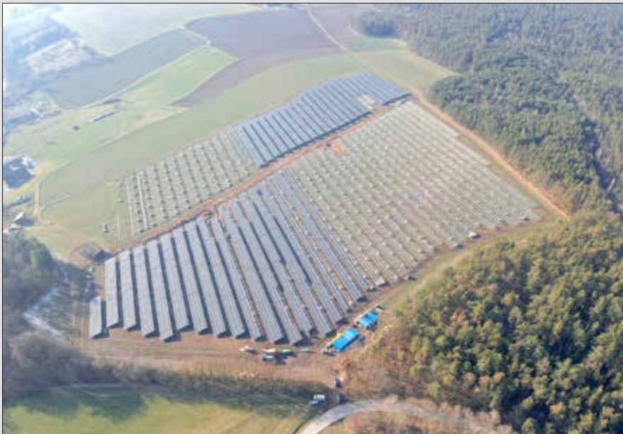
Hier wurden die Solarmodule an die Aufständerung montiert
