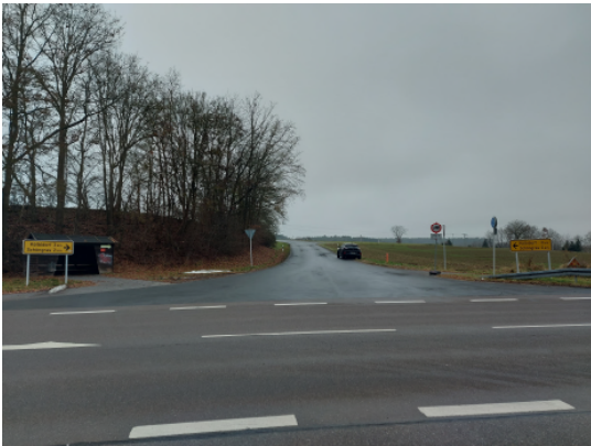
Zufahrt zum Vorhabenstandort
